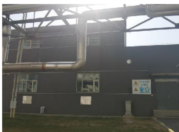
生活污水处理站
