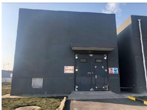
含油废水处理间
