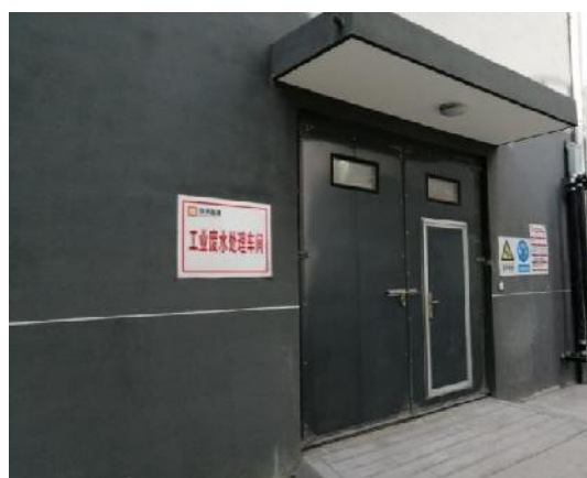
工业废水处理站
