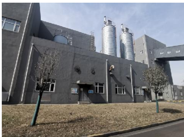
脱硫废水处理站
