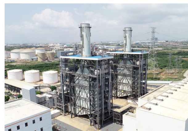
加纳安所固燃气电厂
